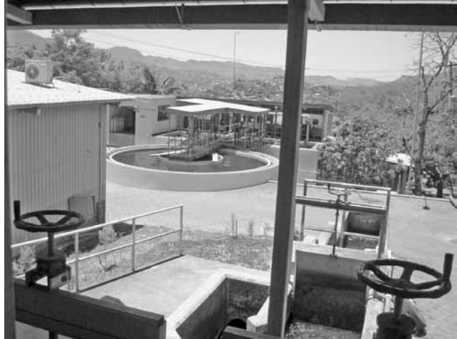
installatie voor drinkwaterproductie foto's: Alfonso Gil Cantabrana
