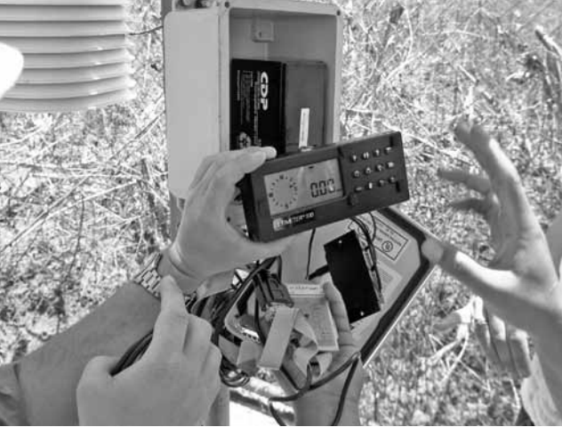
geautomatiseerd weerstation voor het alarmsysteem Comupred
