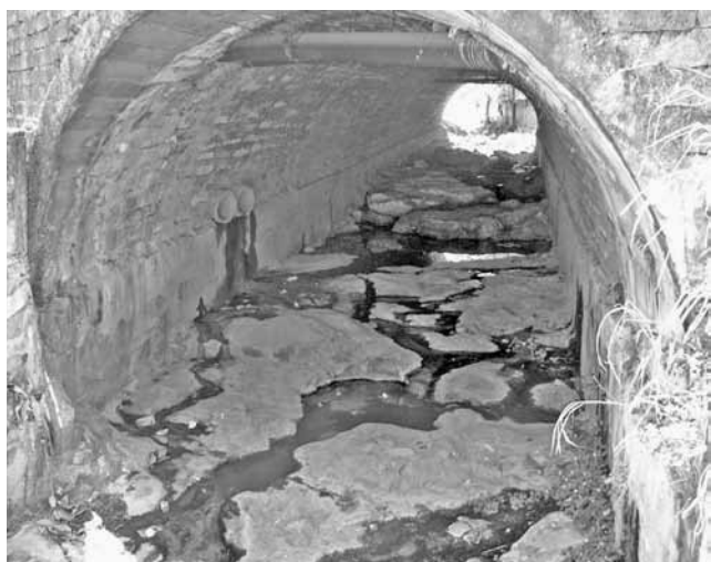
chuisle, overkluizing van de beken onder de stad
